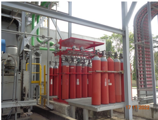
รูปที่ 45 ระบบดับเพลิงแบบใช้ CO 2
