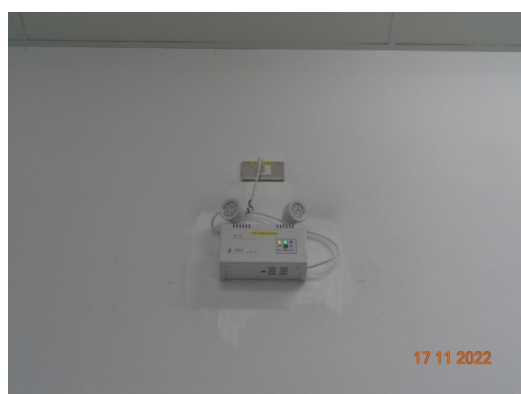
รูปที่ 35 Emergency Light System
