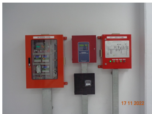
รูปที่ 29 Gas Detector System
