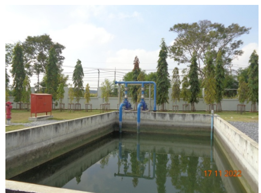
รูปที่ 12 บ่อพักน้ำทิ้งขนาด 100 ลูกบาศก์เมตร
