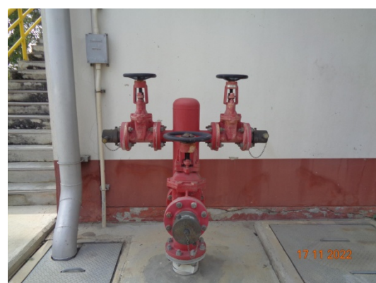
รูปที่ 48 Fire Hydrant
