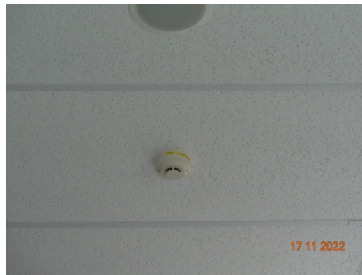
รูปที่ 32 Smoke Detectors
