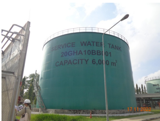
รูปที่ 47 ถังเก็บกักน้ำประปาขนาด 6,000 ลูกบาศก์เมตร
