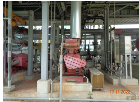
รูปที่ 50 ระบบน้ำดับเพลิงที่ใช้เครื่องยนต์ (Fire Pump)
